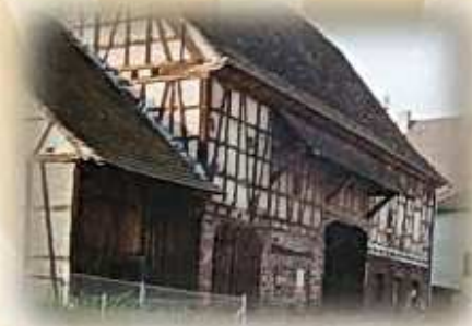
Lammscheuer vor der Sanierung (Ansicht von der Brunnenstraße)
